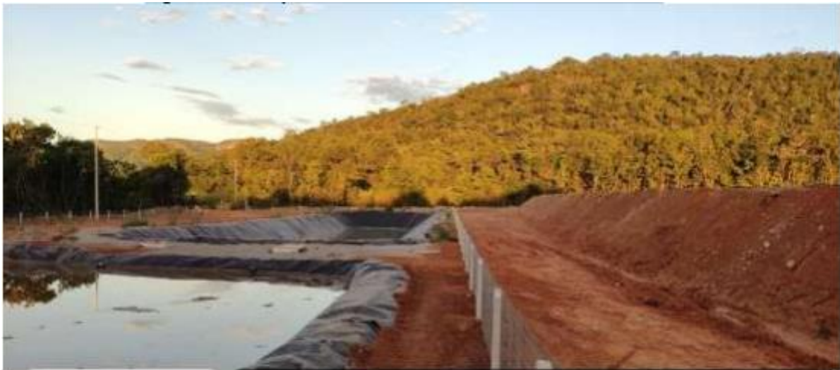
FIGURA 9 - Vista parcial do sistema de tratamento de chorume
